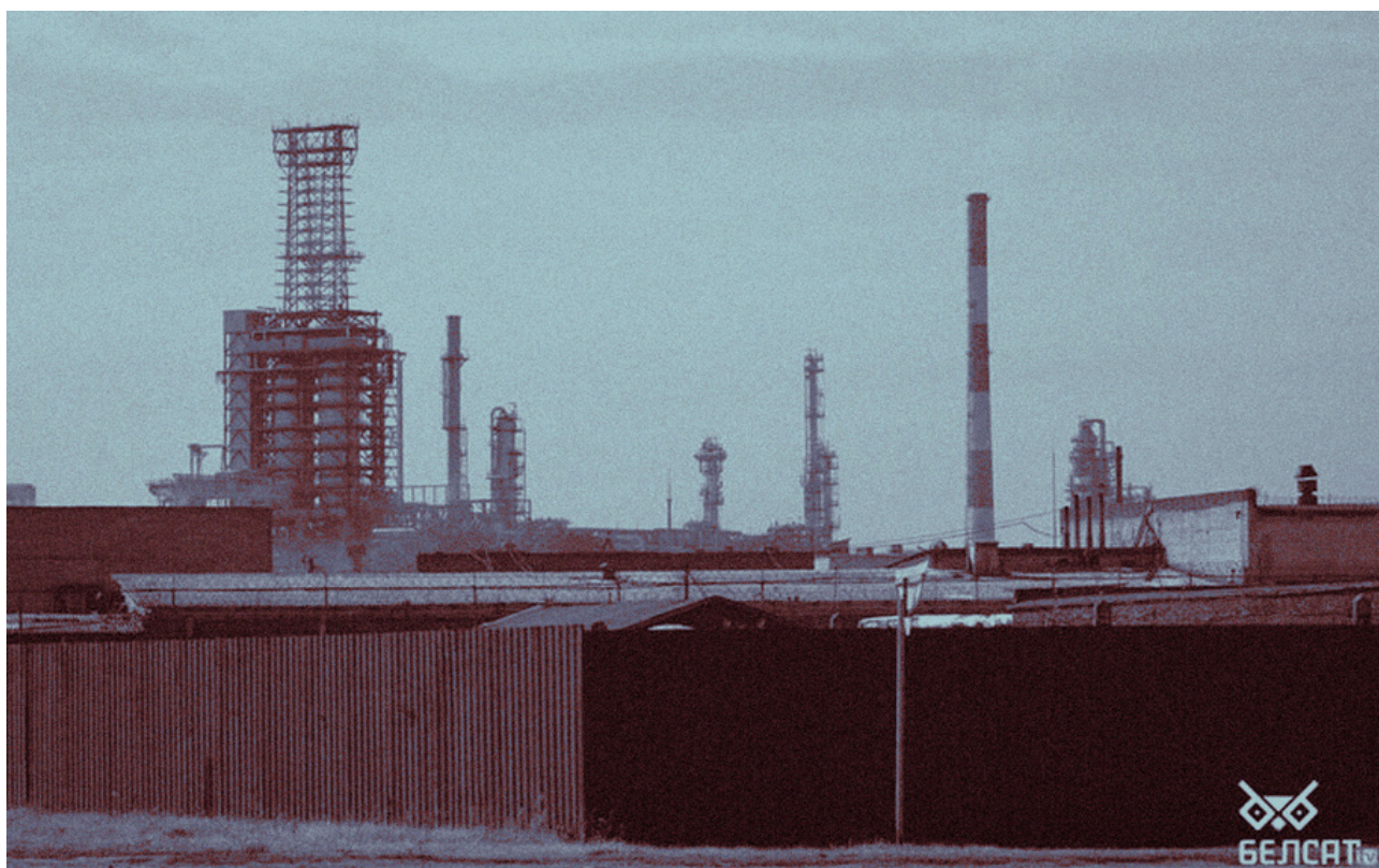
Фото 2. Вид на завод «Нафтан», на переднем плане — Исправительная колония №1. Новополоцк, Беларусь. 11 сентября 2021 года. Фото: Агата Квятковская, «Белсат». Источник: https://news.zerkalo.io/life/101777.html
